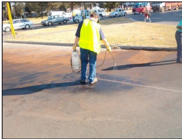
Fumigando con químico sobre la mancha de de diesel que ha quedado.
