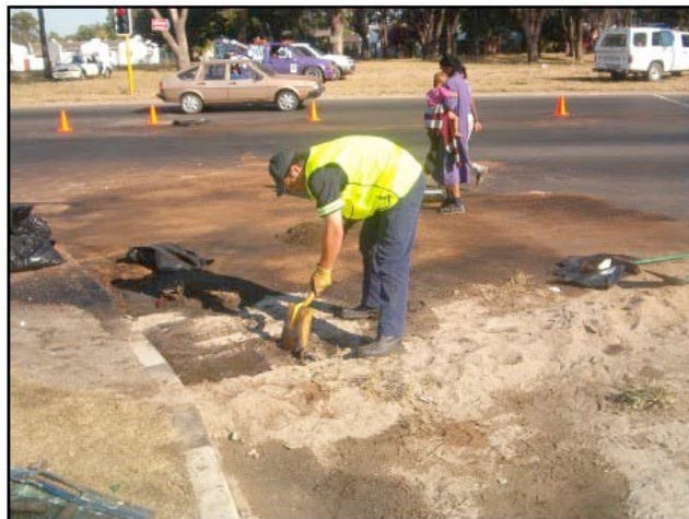
Retirando TURBAMAX contaminado.
