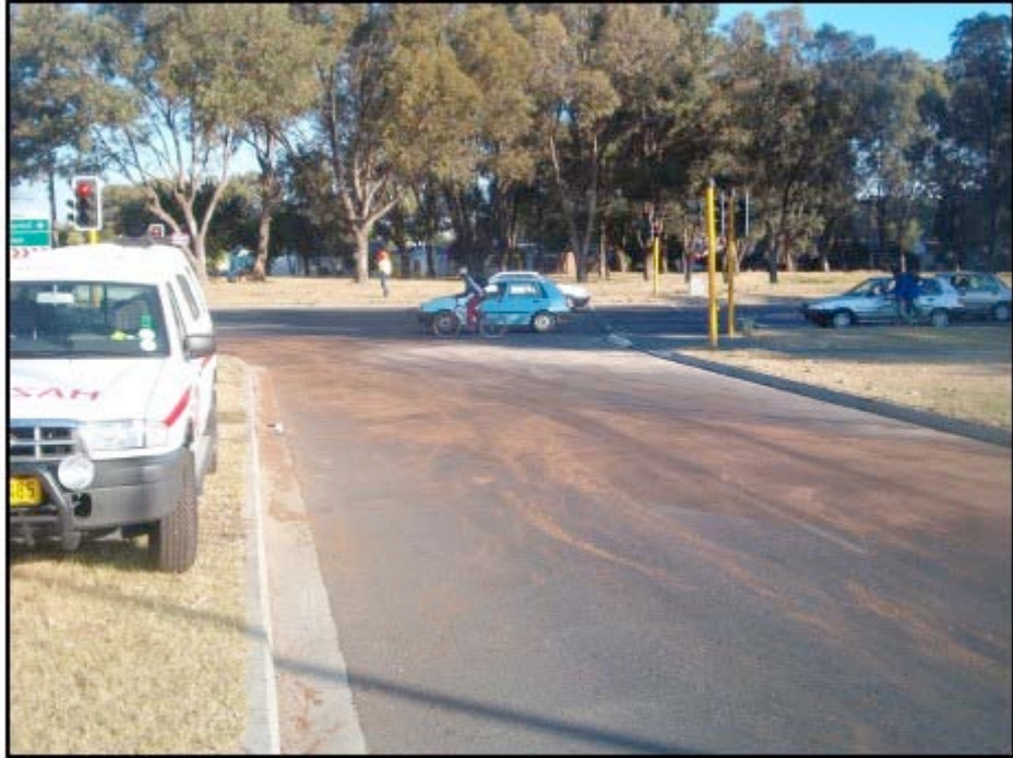
Capa final de TURBAMAX echado en la calzada para absorber los restos de diesel.
