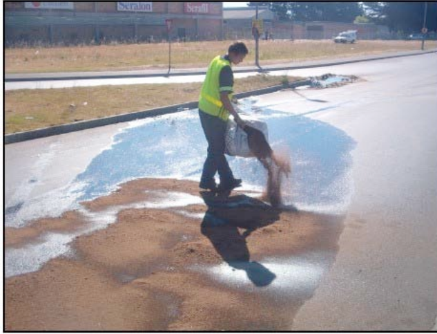
Extendiendo TURBAMAX sobre el vertido.
