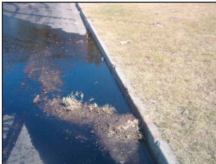
Encharcamiento de diesel en el borde del asfalto junto al bordillo.
